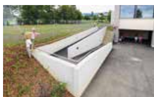
Rampenerschliessung für komplette Rollstuhlgängigkeit.
