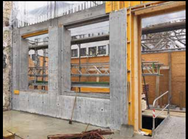
Die Aussenwände in Sichtbeton werden in einem Guss betoniert.
