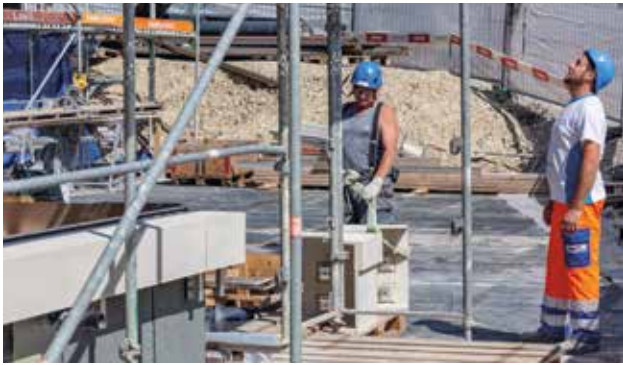
Die zum Teil bis 400 kg schweren Glasfaserbetonelemente erfordern spezielle Hebe- und Haltemittel.
